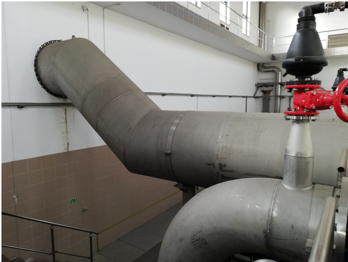
Fot.3. Przedmiotowy odcinek rurociągu DN1200 z planowanym wbudowaniem zasuw.
