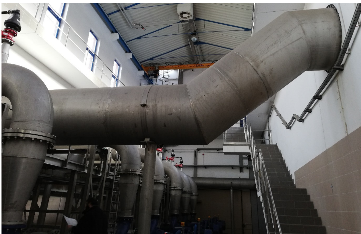
Fot.2. Przedmiotowy odcinek rurociągu DN1200 z planowanym wbudowaniem zasuwy
