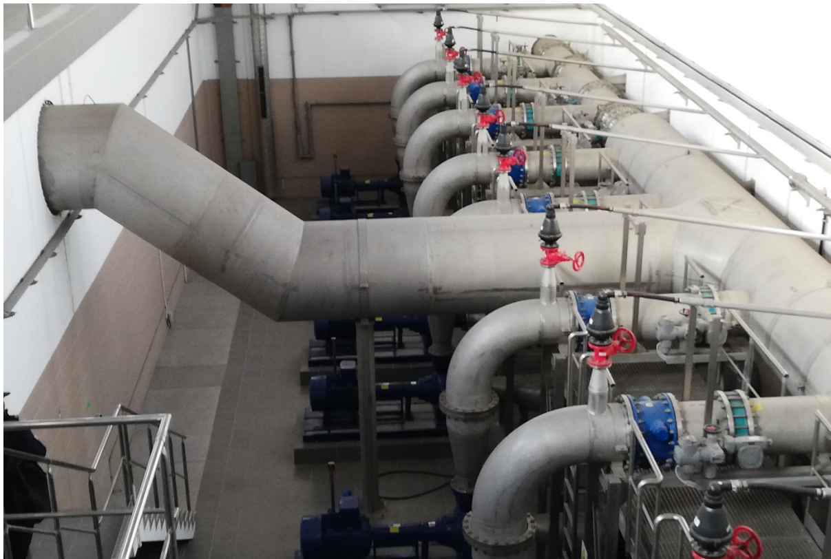
Fot.1. Przedmiotowy odcinek rurociągu DN1200 z planowanym wbudowaniem zasuwy
